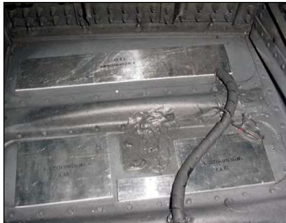
Figura 2.2. Reparación con parches en la superficie interior de una estructura sometida a vibración.
