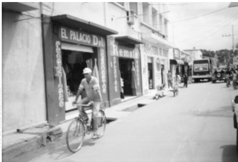
Calle comercial de El Carmen de Bolívar, 2003
